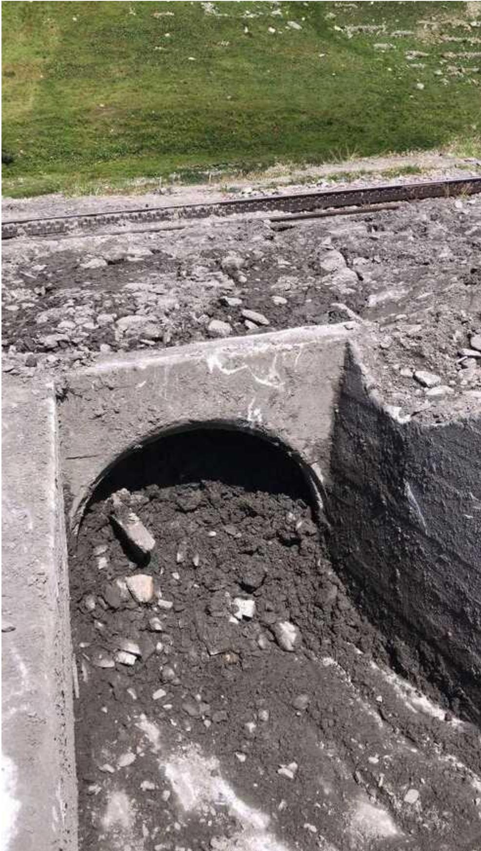
Das Einlaufbauwerk und der Durchlass bei km 49.277 wurden verschüttet, mit dem Einsatz des Baggers Menzi IHI 55 vx wurden etwa 200 m<sup>3</sup> Material ausgeräumt.
